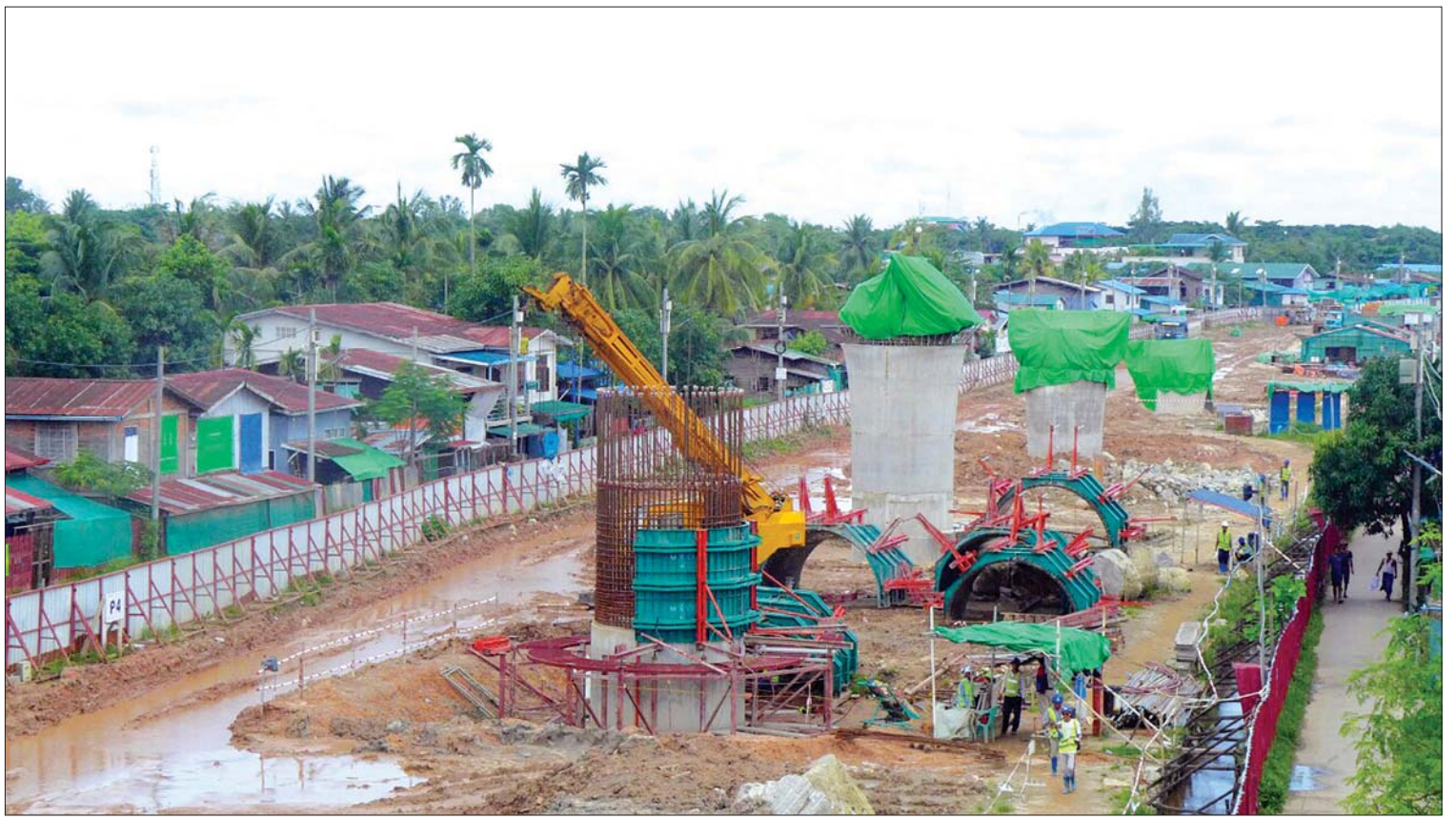
ရန်ကုန်မြို့နှင့် ဒလမြို့တို့ကို ဆက်သွယ်ပေးမည့် ကိုရီးယား-မြန်မာ ချစ်ကြည်ရေး ဒလတံတားကြီး တည်ဆောက်နေမှု လုပ်ငန်းခွင်ကို တွေ့ရစဉ်။
