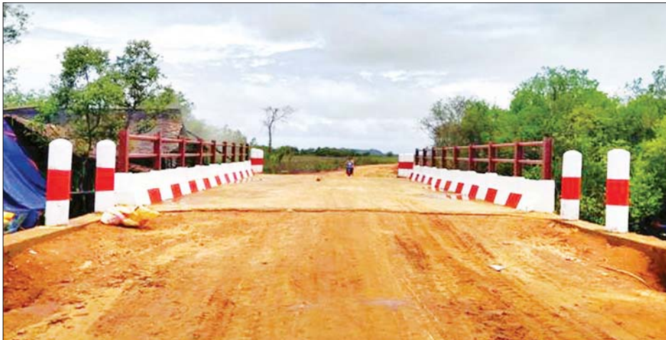
မြိတ်ခရိုင်အတွင်း တည်ဆောက်ပြီးစီးသည့် တံတားတစ်စင်းကို တွေ့ရစဉ်။
