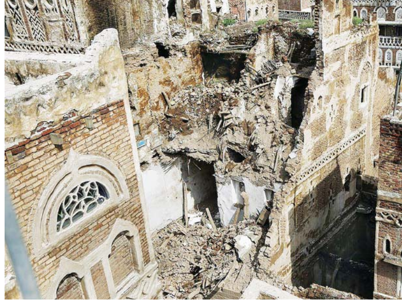
မိုးသည်းထန်စွာ ရွာသွန်းမှုကြောင့် ယီမင်နိုင်ငံ ဆာနားရှိ သမိုင်းဝင်အဆောက်အအုံပြုကျပျက်စီးခဲ့မှုကို တွေ့ရစဉ်။
