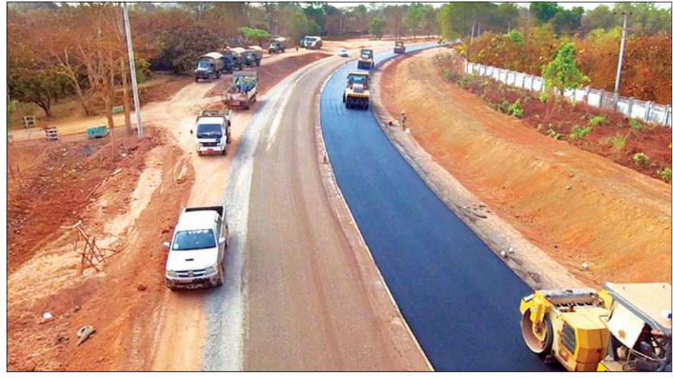
အိန္ဒြ - ကော့ကရိတ်လမ်း နိုင်ငံလွန်ကတ္တရာခင်းခြင်း လုပ်ငန်းဆောင်ရွက်နေမှုကို တွေ့ရစဉ်။
