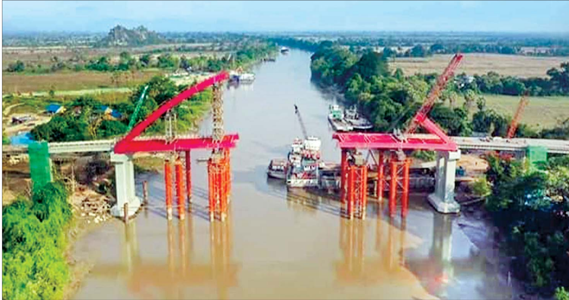
ကျိုက်မရော - စံပယ်ဂူ - ကော့ပနောလမ်းပေါ်ရှိ အတ္ထရိုမြစ်ကူး(စံပယ်ဂူ) တံတားစီမံကိန်း တည်ဆောက်ရေးလုပ်ငန်း ဆောင်ရွက်နေမှုကို တွေ့ရစဉ်။
