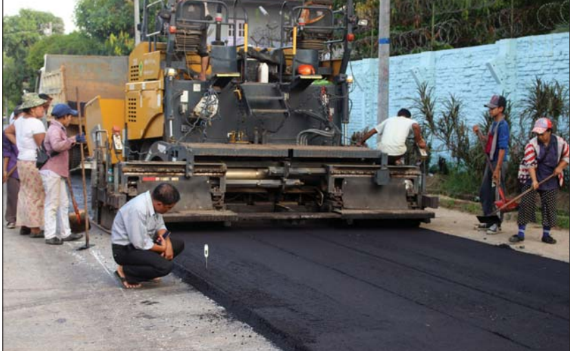
နိုင်လွန်ကတ္တရာခင်းသည့်လုပ်ငန်းကို စက်ယန္တရားကြီးများဖြင့် ဆောင်ရွက်နေစဉ်။
