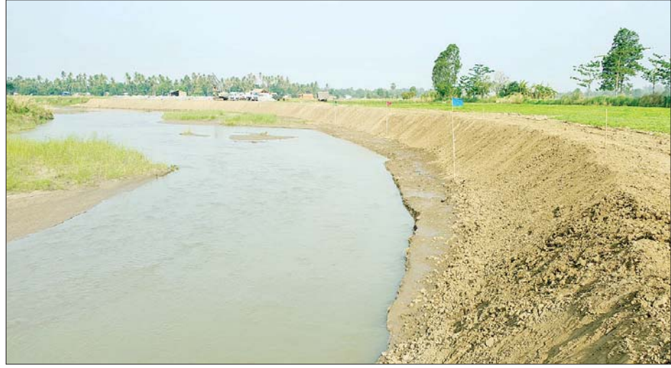
ရေလွှဲရေကာတာတည်ဆောက်ရန် လျာထားနေရာကို တွေ့ရစဉ်။
