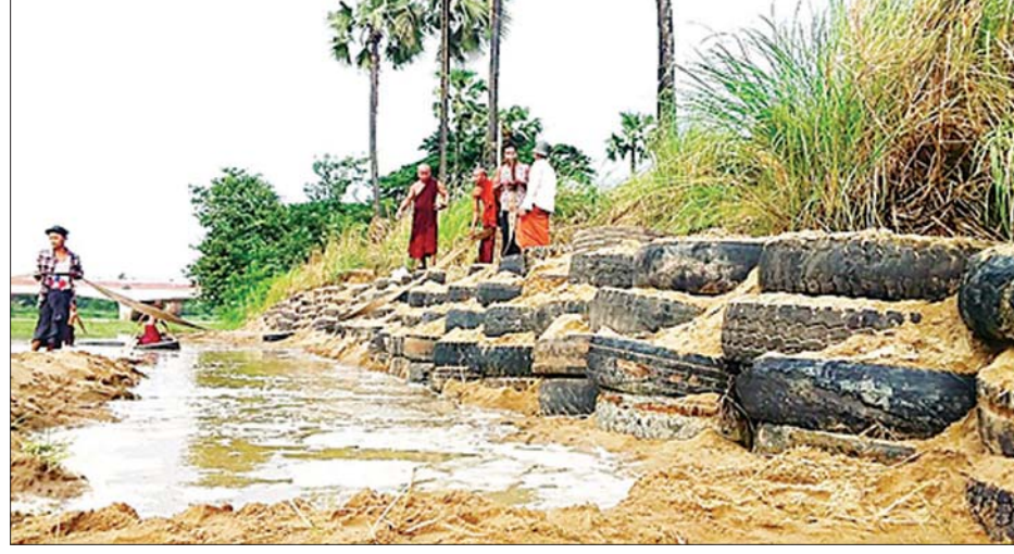
တာယာအဟောင်းများ အသုံးပြုကာ ကမ်းပြိုကာကွယ်ရေးအတွက် တည်ဆောက်နေမှုကို တွေ့ရစဉ်။
