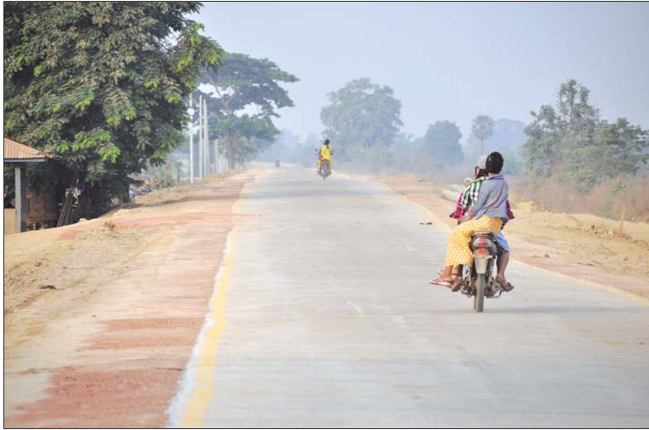
ဥက္ကံ-တဘူးလှဆည်လမ်းပိုင်းအား ကွန်ကရစ်လမ်းခင်းပြီး တွေ့ရစဉ်။
