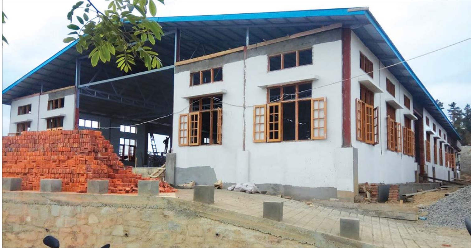
အစိုးရစက်မှုလက်မှုသိပ္ပံ(ဟားခါး)ရှိ အလုပ်ရုံ Steel Structure (၁)ထပ် တည်ဆောက်နေမှုကို တွေ့ရစဉ်။
