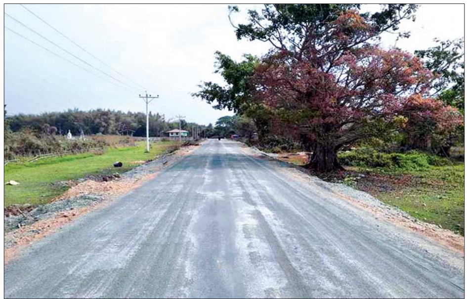
ဟိုပင် - နန့်မွန်း - ညောင်ပင် - ဝေခါလမ်း ၅၃ ဒသမ ၂၉ ကီလိုမီတာနှင့် ၅၆ ဒသမ ၂၉ ကီလိုမီတာ အကြား ကတ္တရာ လမ်းချဲ့ထွင်ခင်းကျင်းဆောင်ရွက်ပြီးစီးမှုကို တွေ့ရစဉ်။
