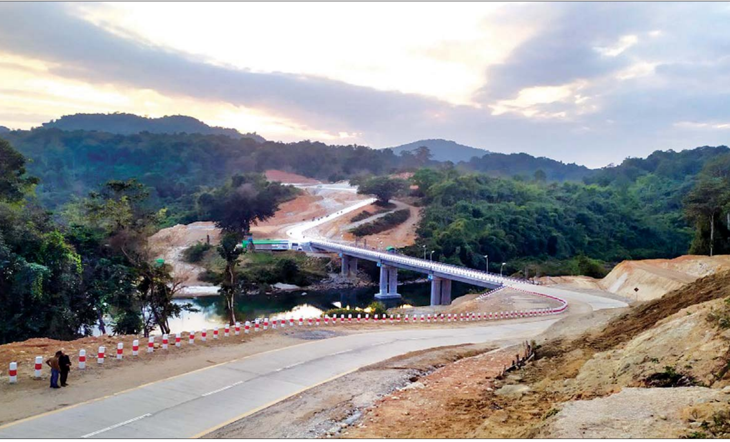
မချမ်းဘော့ - ဖရေ - ရပ်ဘော့ - နောင်မွန်လမ်းပေါ်ရှိ တံတားအမှတ်(၁/၈) ထိခတ်တား၏ ချဉ်းကပ်လမ်း ကွန်ကရစ်ခင်းဆောင်ရွက်ထားမှုကို တွေ့ရစဉ်။
