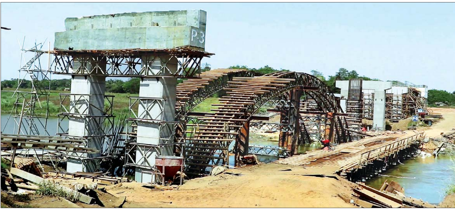
ပဲခူး- ရန်ကုန် ဆက်သွယ်သွားလာနိုင်မည့် မြို့ဦးကင်းတံတား တည်ဆောက်ပြီးစီးမှုကို တွေ့ရစဉ်။
