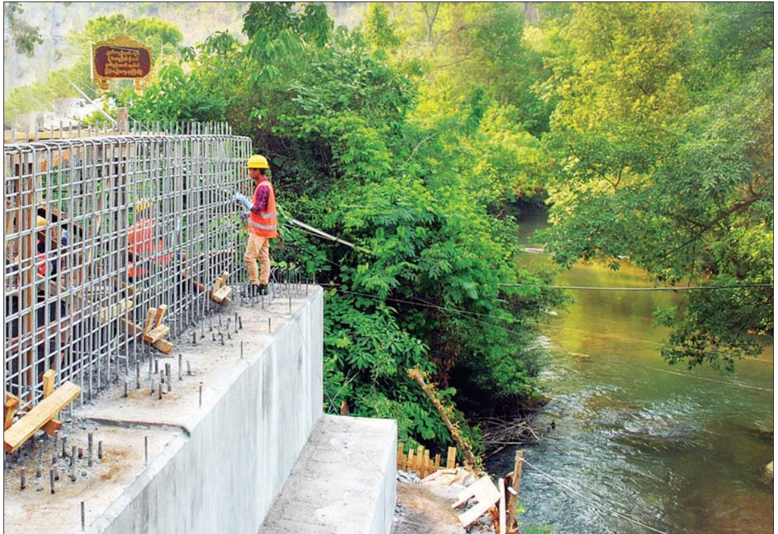
မောက်မယ်-ဝမ်ဟတ်-လင်းခေးတံတား တည်ဆောက်နေမှုကို တွေ့ရစဉ်။
