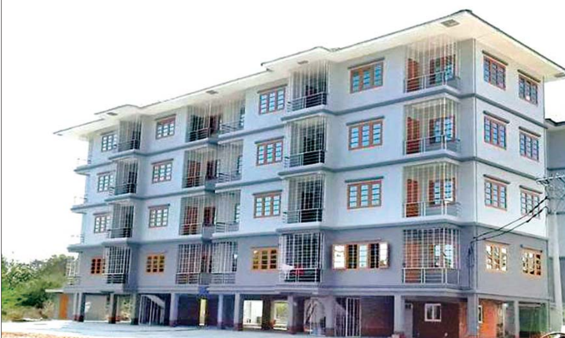
၂၄-၉-၂၀၁၉ ရက်က ဆောင်ရွက်ပြီးစီးခဲ့သော မုံရွာမြို့ ဝန်ထမ်းအိမ်ရာ အဆောက်အအုံကို တွေ့ရစဉ်။
