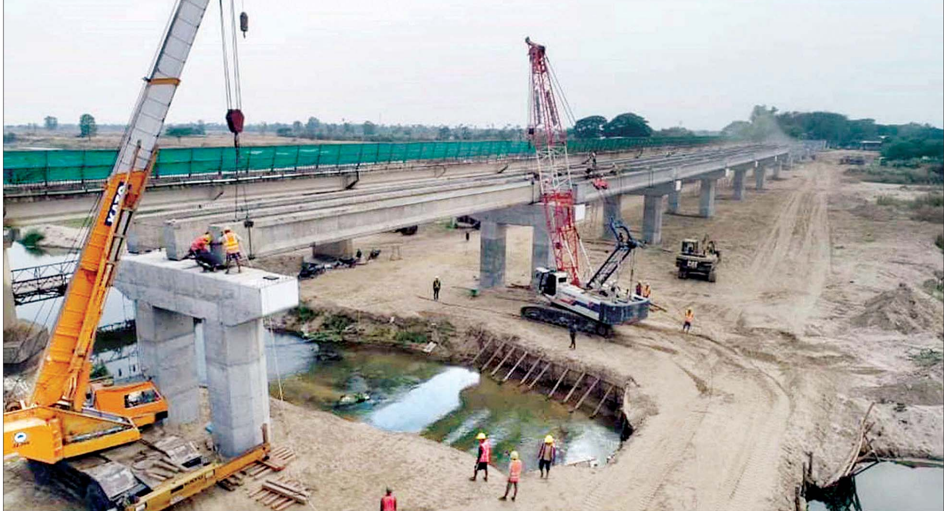
မူးမြစ်ကူးတံတား(ရေဦး) တည်ဆောက်ခြင်းလုပ်ငန်း ဆောင်ရွက်နေစဉ်။
