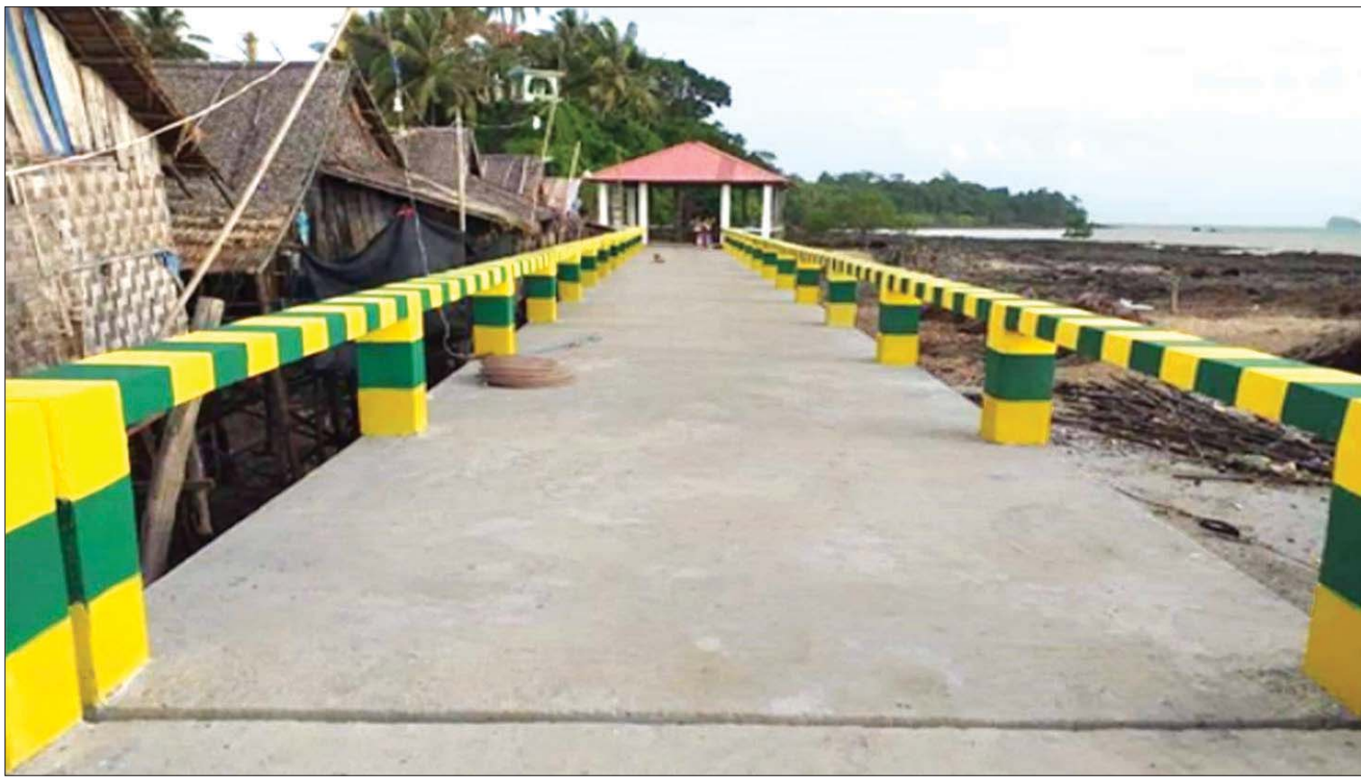
၂၀၁၈-၂၀၁၉ ဘဏ္ဍာရေးနှစ် ကော့သောင်းမြို့နယ် အောင်မြန်မာကျေးရွာ ရေဆင်းဆိပ်ခံ ပေ ၄၀၀ တံတားတည်ဆောက်ထားမှုကို တွေ့ရစဉ်။
