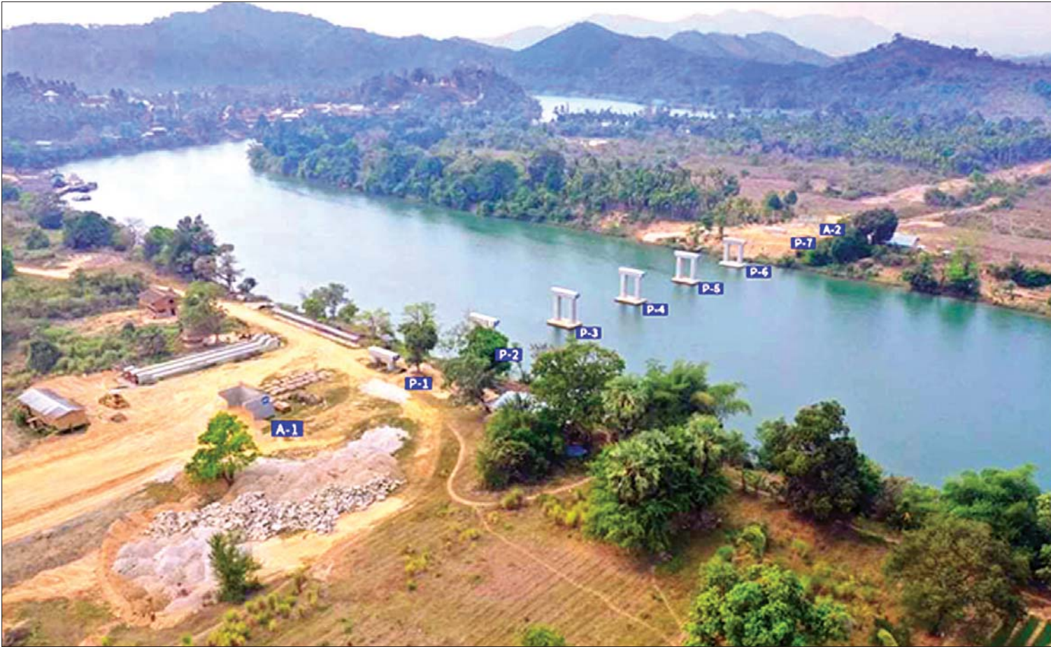
၂၀၁၉-၂၀၂၀ ခု ဘဏ္ဍာရေးနှစ်တွင် တံတားဦးစီးဌာန တည်ဆောက်ရေးအဖွဲ့(၄) က တည်ဆောက်လျက်ရှိသည့် ဗောဓိကမ်းတံတားကို တွေ့ရစဉ်။
