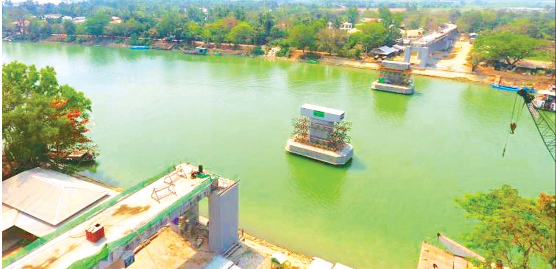
ဝါးခယ်မမြို့နယ် ပန်းတနော်-ရွှေလောင်း - ဝါးခယ်မ- ကျုံမငေးလမ်းပေါ်ရှိ ရွှေလောင်းတံတား တည်ဆောက်နေမှုကို တွေ့ရစဉ်။
