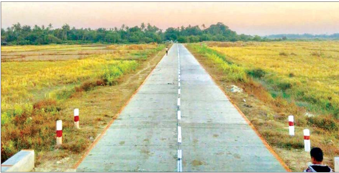
၂၀၁၈-၂၀၁၉ ဘဏ္ဍာရေးနှစ်တွင် ရသေ့တောင်မြို့နယ် ဘူးသီးတောင်-အငူမော်လမ်း မြေသားလမ်းချဲ့ခြင်းနှင့် ကွန်ကရစ်ခင်းခြင်းလုပ်ငန်း ဆောင်ရွက်ပြီးစီးမှုကို တွေ့ရစဉ်။
