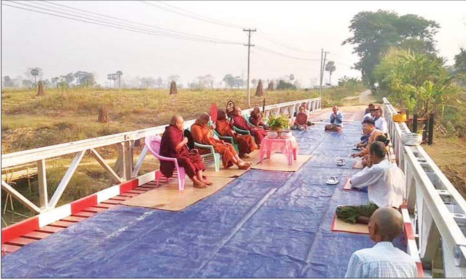
ကျွဲပိပုလဲမြို့နယ်တွင် ဆောင်ရွက်သော ဘေလီတံတား အမျိုးအစားဖြစ်ပြီး တင်ဒါအောင် ဟန်သီရိကုမ္ပဏီ လီမိတက်မှ တာဝန်ယူဆောင်ရွက်ခြင်းဖြစ်ကြောင်း၊ စာရေးကွင်း၊ ကျွဲပိညောင်ဝိုင်း၊ အိုင်သပြေကျေးရွာများသို့ ဆက်သွယ်ထားသော တံတားဖြစ်ပြီး တံတားခံနိုင်ရည်မှာ ယာဉ်ကုန်တန် ၁၃ တန်အထိ သတ်မှတ်ထားကြောင်း စာရေးကွင်းကျေးရွာအုပ်စု အုပ်ချုပ်ရေးမှူး ဦးအောင်သူထံမှ သိရသည်။ ရွှေမိုး(ပြန်/ဆက်)
