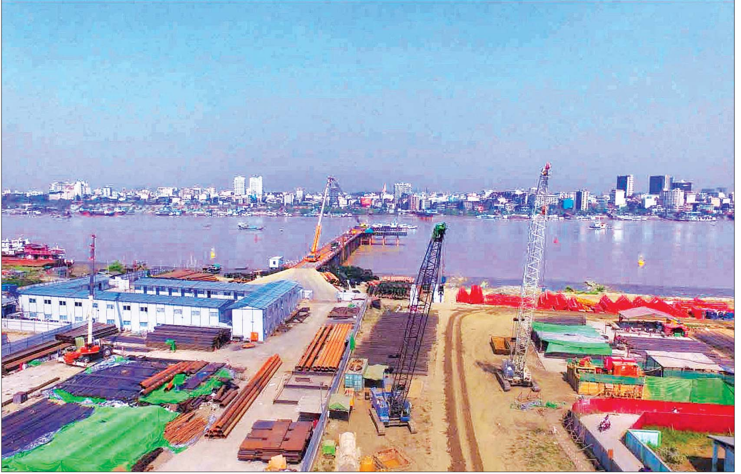
ရန်ကုန်တိုင်းဒေသကြီး လမ်းမတော်မြို့နယ်နှင့် ဒလမြို့နယ်တို့ကို ရန်ကုန်မြစ်အား ဖြတ်သန်း၍ ဆက်သွယ်တည်ဆောက်နေသော မြန်မာ-ကိုရီးယားချစ်ကြည်ရေး (ဒလ) တံတား စီမံကိန်း ကို တွေ့ရစဉ်။
