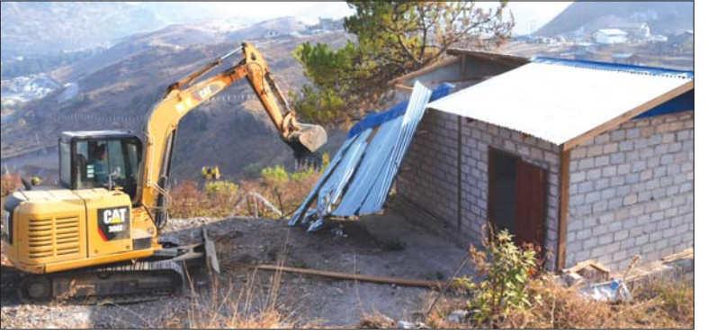
ကျူးကျော်အဆောက်အအုံတစ်ခုကို ဖြိုချရှင်းလင်းနေစဉ်။
