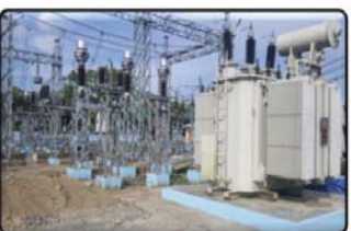
စစ်တွေ ဓာတ်အားခွဲရုံတွင် ၆၆/၁၁ ကေစီ ၅ အမီစီအေ ထရန်စဖော်မာ တိုးချဲ့တပ်ဆင် ဆောင်ရွက်ပြီးစီးခြင်း
