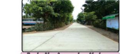
ဝှမြို့နယ် ရဟိုက်ကူးတိုကျေးရွာအုပ်စု၊ ရဟိုက်ကူးကျေးရွာတွင် ကုန်ကရစ်လမ်းအဖြစ် အဆင့်မြှင့်တင်ခြင်းလုပ်ငန်း ဆောင်ရွက်ပြီးစီးမှု
