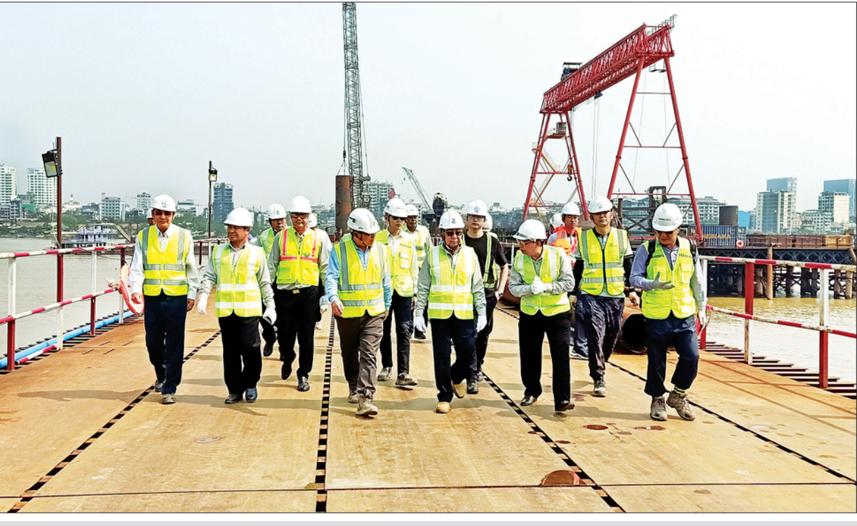
ပြည်ထောင်စုဝန်ကြီး ဦးဟန်ဇော် မြန်မာ - ကိုရီးယား ချစ်ကြည်ရေး (ဒလ) တံတားတည်ဆောက်ရေးစီမံကိန်းအတွင်း ကြည့်ရှုစစ်ဆေးစဉ်။ သတင်းစဉ်
