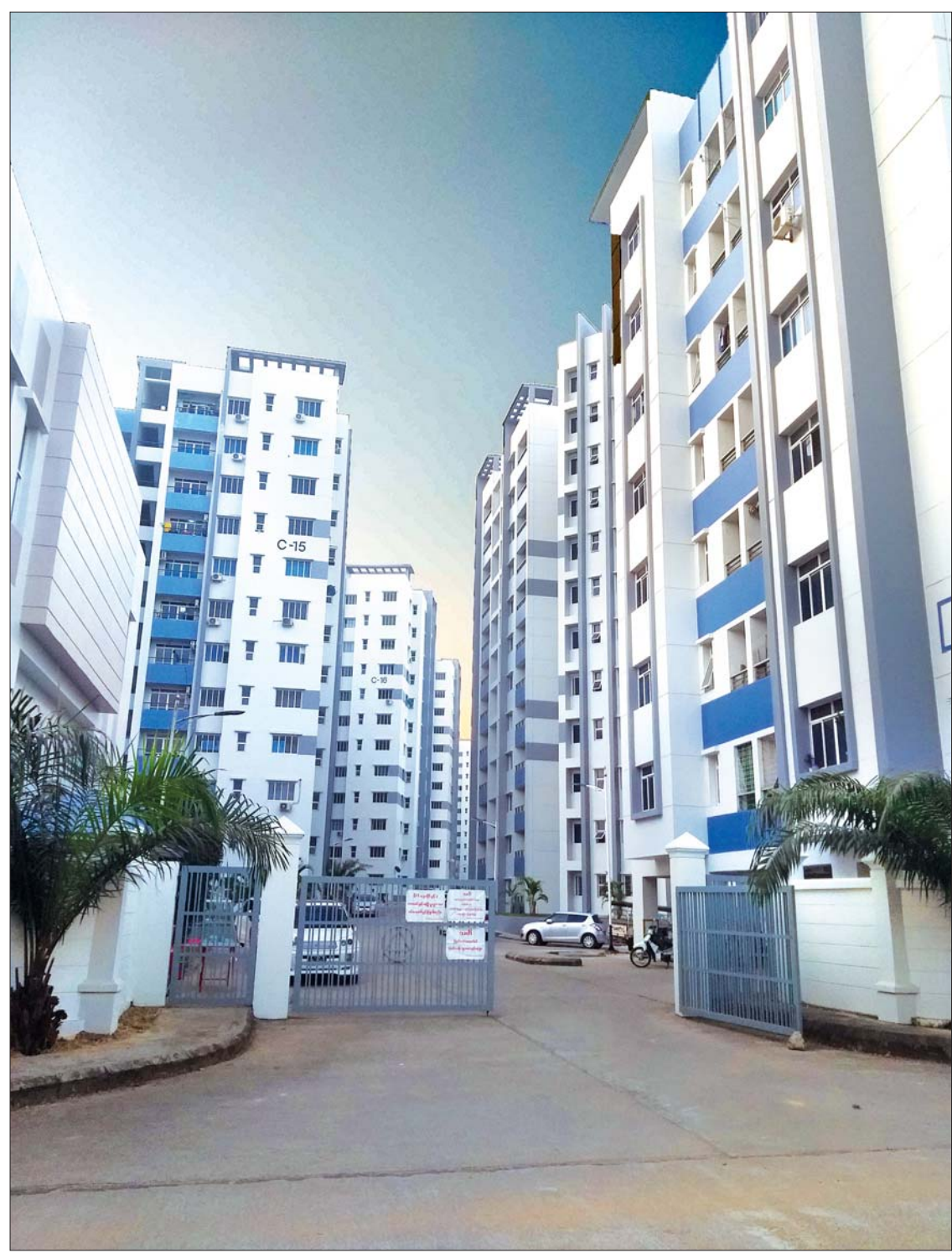
ရန်ကင်းမြို့ရှိ အထပ်မြင့်အဆောက်အအုံများ ဆောက်လုပ်ထားမှုကို တွေ့ရစဉ်။
