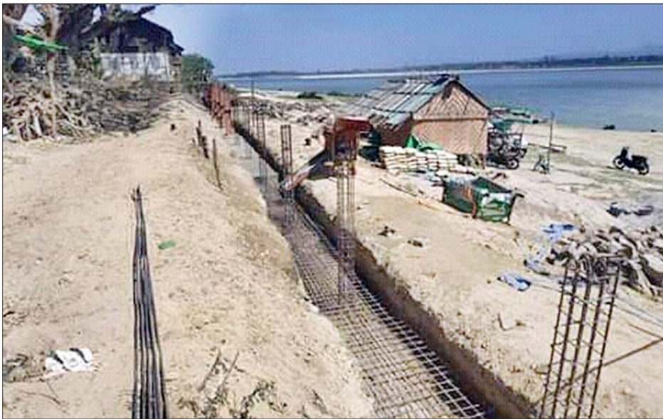
မလယ်ကျေးရွာတွင် ကမ်းပြိုကာကွယ်ရေးလုပ်ငန်းများဆောင်ရွက်နေစဉ်။
