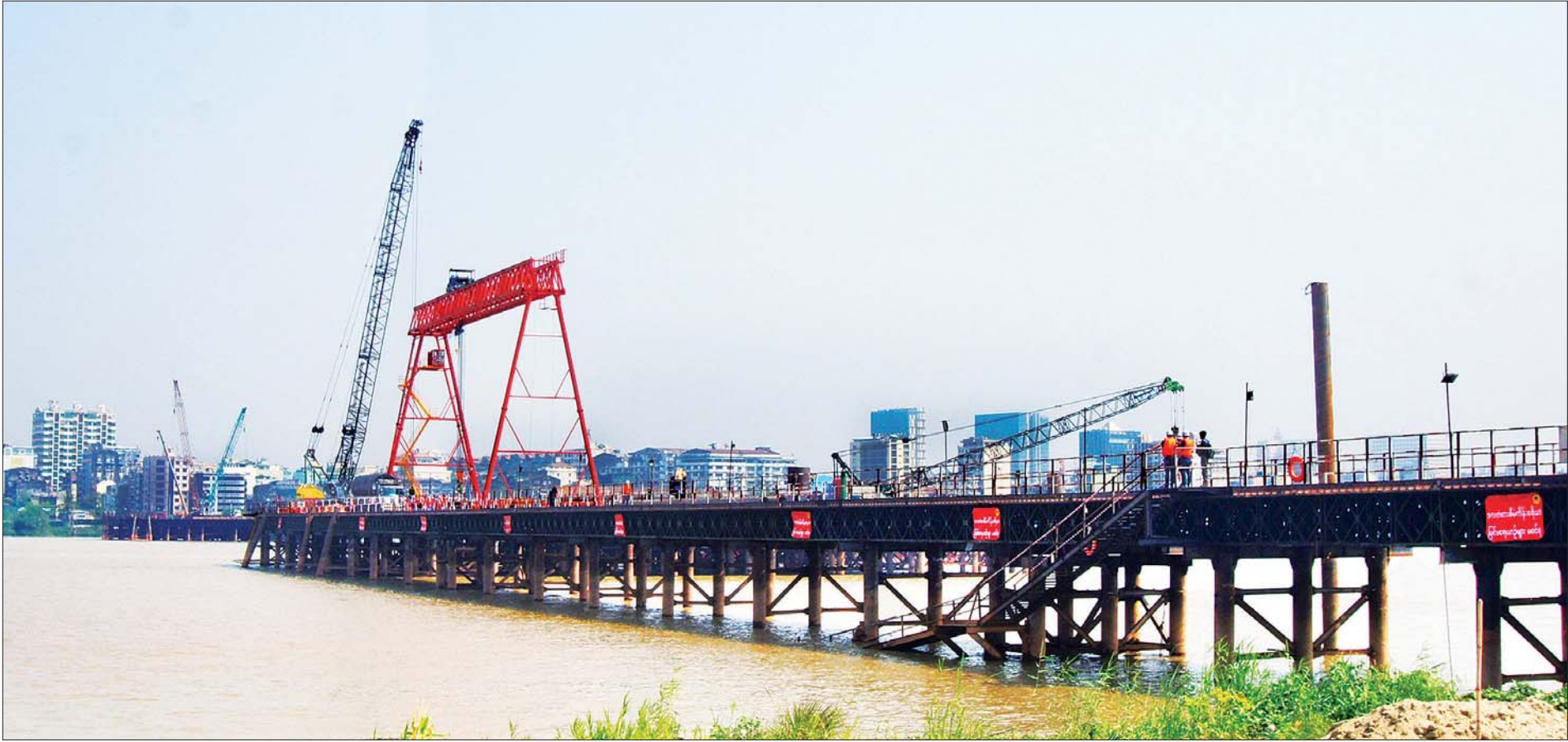
ကိုရီးယား-မြန်မာ ချစ်ကြည်ရေး(ဒလ) တံတားအား စက်ယန္တရားများဖြင့် တည်ဆောက်နေမှုကို ဒလမြို့နယ်ဘက်ခြမ်းမှ တွေ့ရစဉ်။
