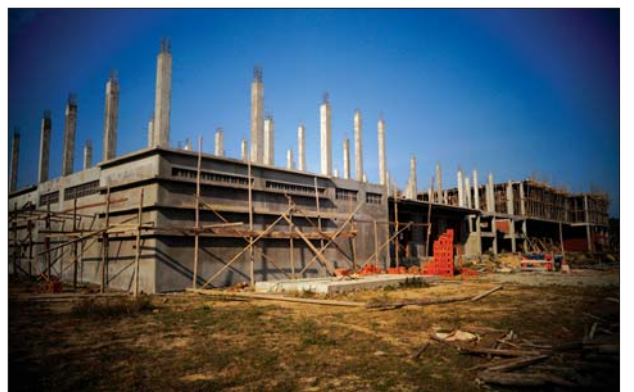
ဆောက်လုပ်နေဆဲ ကျောင်းဆောင်အဆောက်အအုံ။
