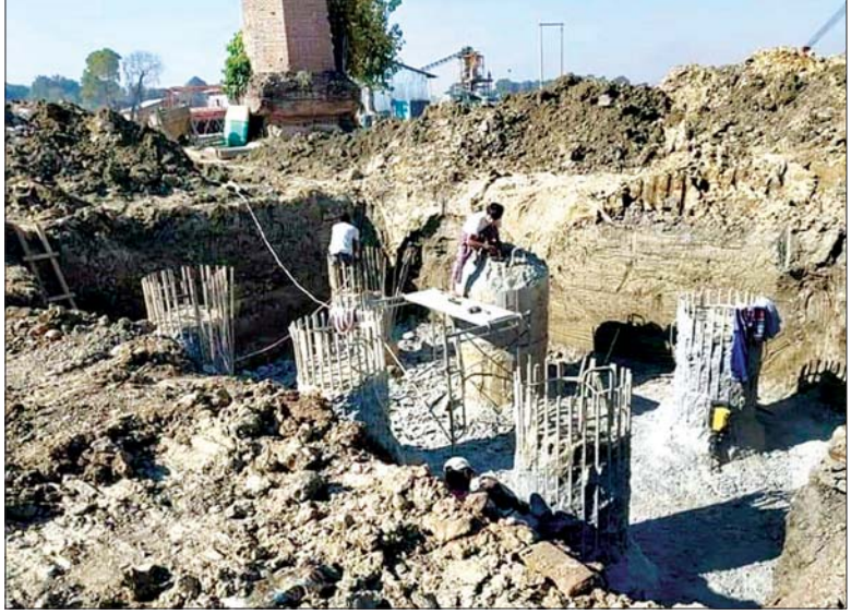
ဧရာဝတီတံတား(သရက်-အောင်လံ) တည်ဆောက်ရေးလုပ်ငန်းခွင်အား တွေ့ရစဉ်။
