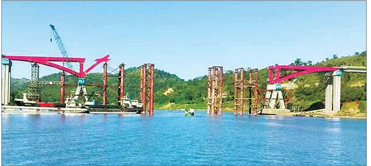
ကုလားတန်မြစ်ကူးတံတား (ပလက်ဝ) တည်ဆောက်ရေးလုပ်ငန်းခွင်ကို တွေ့ရစဉ်။
