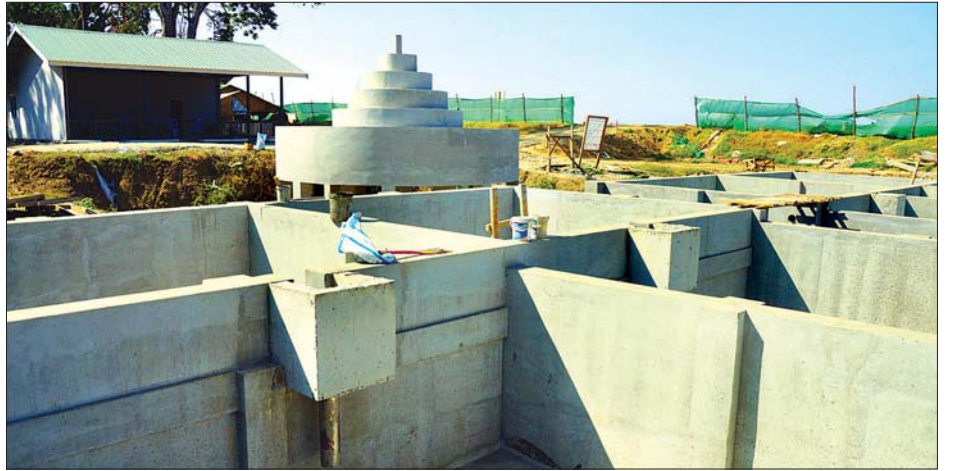
တည်ဆောက်ဆဲဖြစ်သော ရေသန့်စက်ရုံကို တွေ့ရစဉ်။
