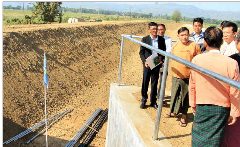
တိုင်းဒေသကြီး ဝန်ကြီးချုပ် ဦးဝင်းသိန်း ဖြူးချောင်းဆည်ရေသောက်စနစ်တည်ဆောက်နေမှုအား ကြည့်ရှုစစ်ဆေးစဉ်။
