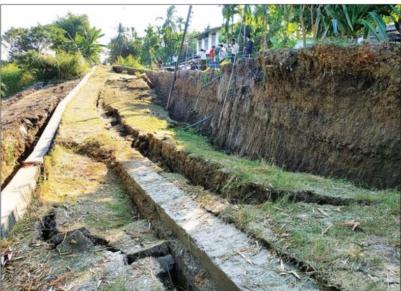
မြစ်ကမ်းထိန်းအုတ်ရိုးများ ကျိုးပြတ်မှုနှင့် မြေသားနိမ့်ကျမှုများ ဆက်လက်ဖြစ်ပေါ်နေသည့် နေရာကို တွေ့ရစဉ်။
