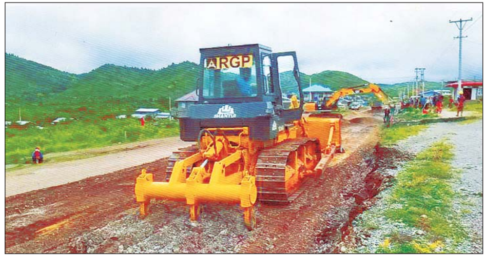
လှည်းကုန်း-အင်းတိန် ကျေးလက်လမ်း ကတ္တရာခင်းရန်အတွက် မြေညှိဆောင်ရွက်နေစဉ်။
