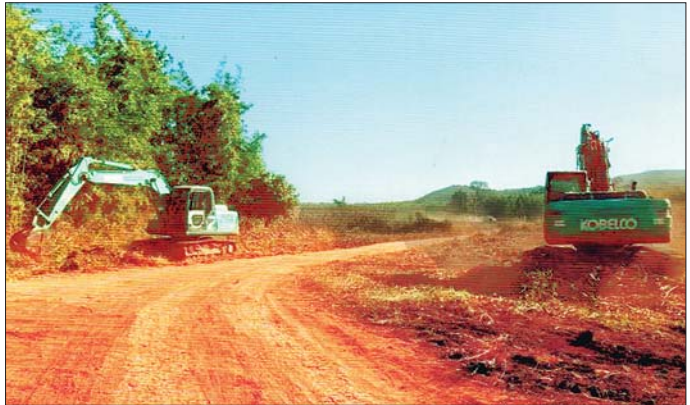
အင်းလေးကန် အနောက်ပတ်လမ်းကို ကျေးလက်လမ်းဦးစီးက စက်ယန္တရားများဖြင့် ဖောက်လုပ်နေမှုကို တွေ့ရစဉ်။
