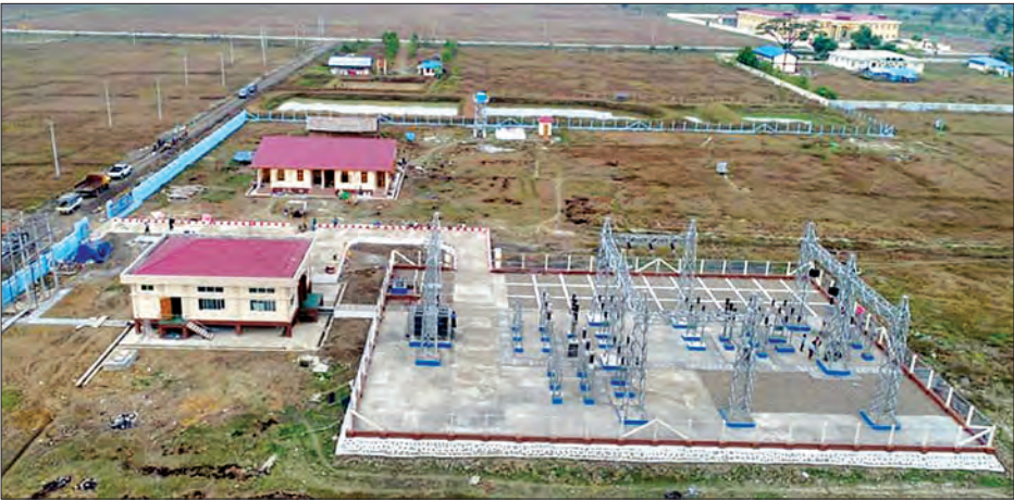
မောင်တောမြို့ရှိ ၆၆/၁၁ ကေစီ ၅ အမ်ပီအေ ဓာတ်အားခွဲရုံ တည်ဆောက်ပြီးစီးမှုအခြေအနေကို တွေ့ရစဉ်။
