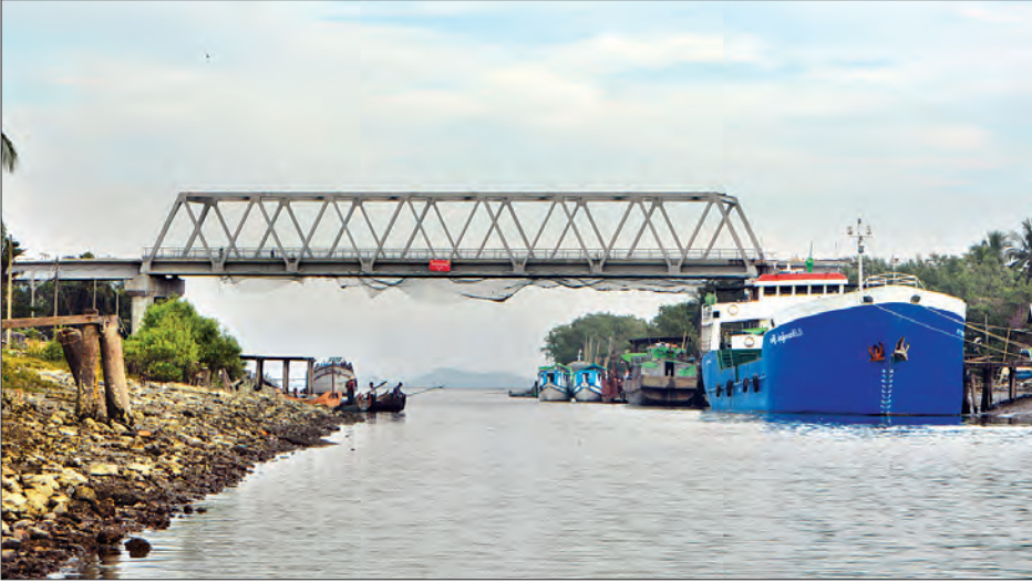
စစ်တွေမြို့ရှိ ဆတ်ရိုးကျတံတား တည်ဆောက်ပြီးစီးမှုကို တွေ့ရစဉ်။
