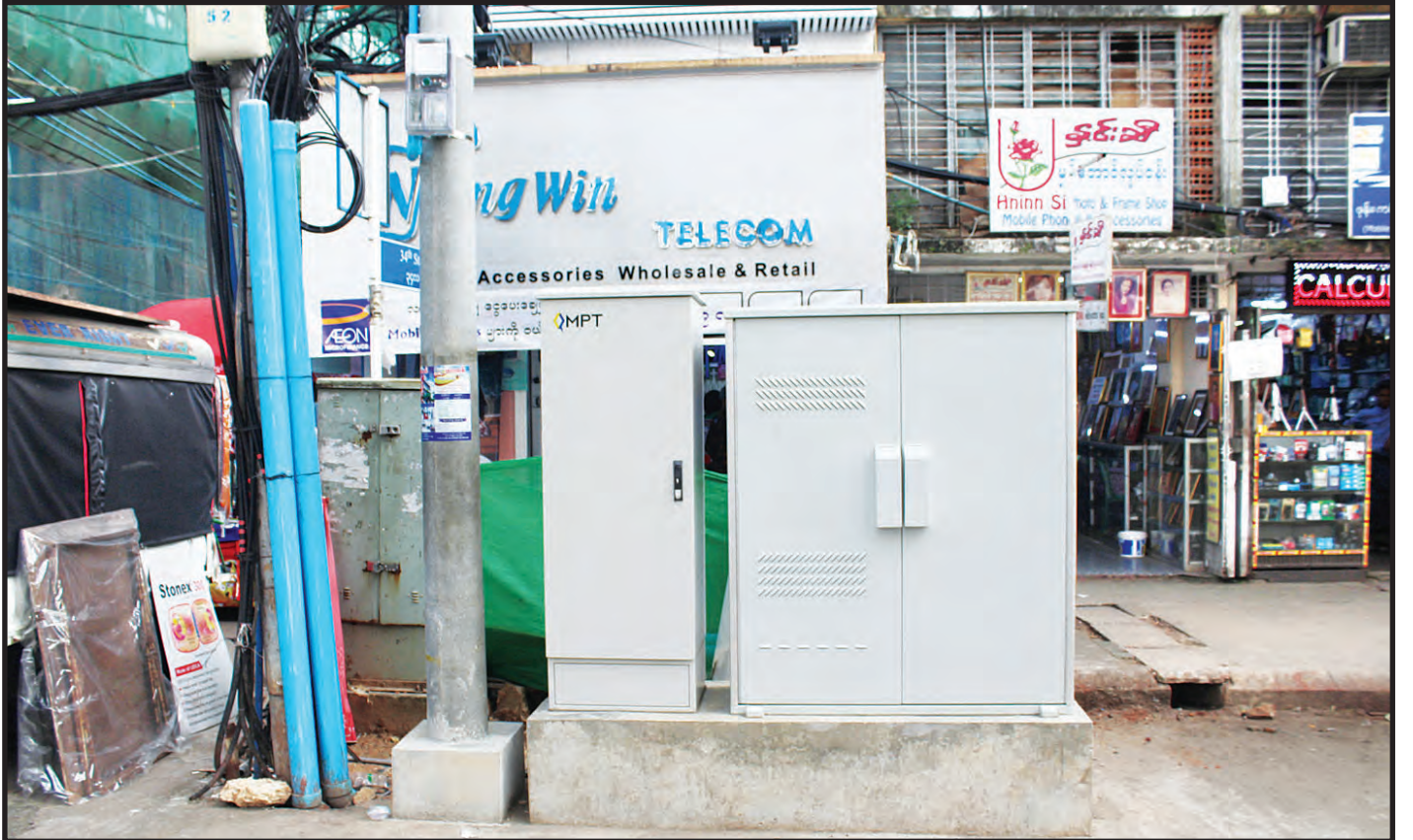
အနော်ရထာလမ်းနှင့် ၃၄ လမ်းထောင့်၌ ရှုပ်ထွေးဆက်သွယ်ရေးကြိုးများကို ရှင်းလင်းအပြီး တွေ့ရစဉ်။
