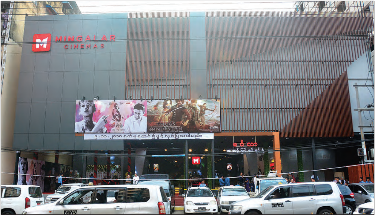
အသစ်ဖွင့်လှစ်လိုက်သည့် မင်္ဂလာအဆင့်မြင့် (တာမွေ) ရုပ်ရှင်ရုံသစ် အဆောက်အအုံကို တွေ့ရစဉ်။
