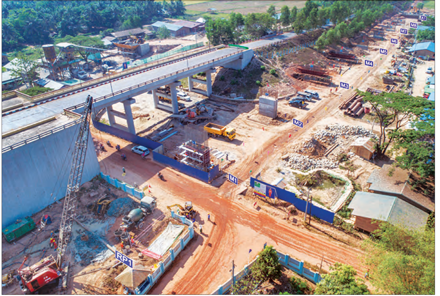
၁၂-၄-၂၀၁၈ ရက်က မြောင်းမြဘက်ကမ်း မြောင်းမြတံတားတည်ဆောက်ရေးလုပ်ငန်းများ လုပ်ဆောင်နေမှုကို တွေ့ရစဉ်။
