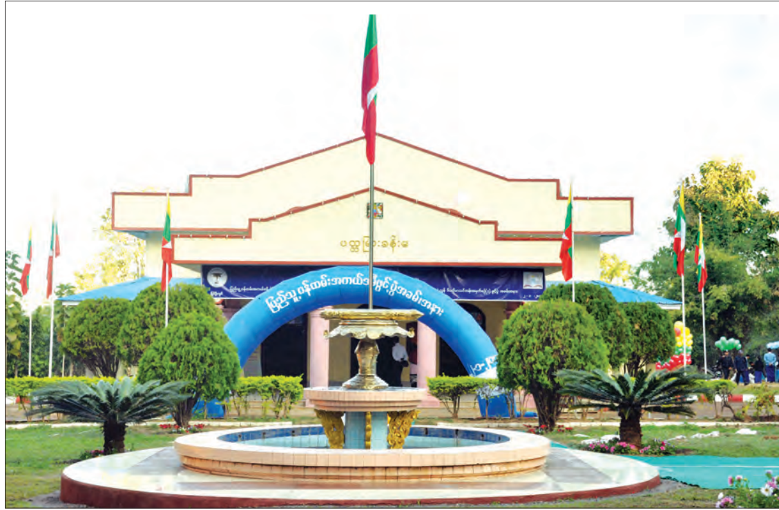
ဗဟိုဝန်ထမ်းတက္ကသိုလ် (အထက်မြန်မာပြည်) ရှိ ပတ္တမြားခန်းမအဆောက်အအုံကို တွေ့ရစဉ်။
