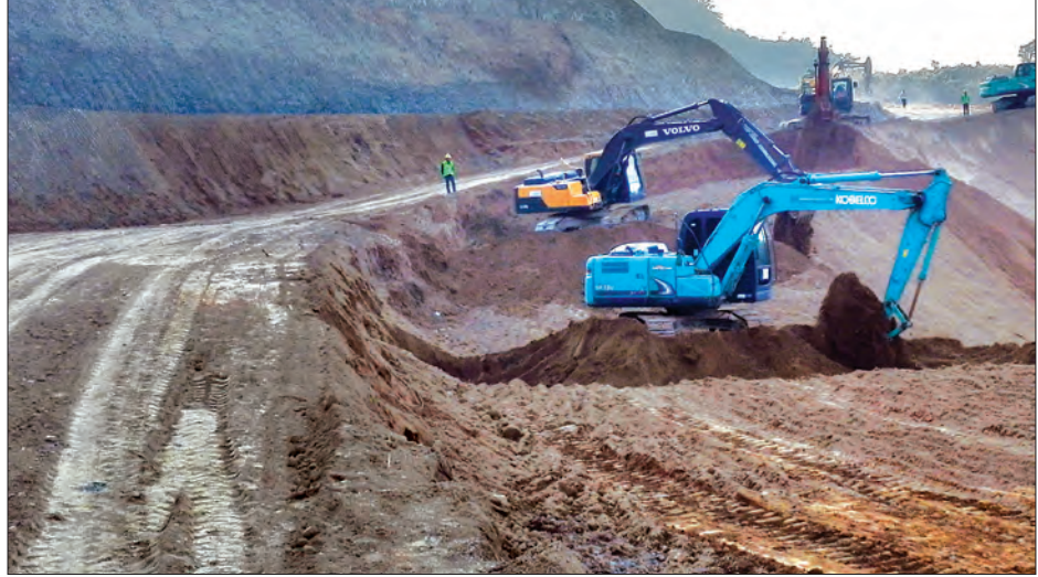
အင်ဒိုနီးရှား-မောင်တော လမ်းပိုင်းတွင် ယာဉ်ယန္တရားကြီးများဖြင့် လုပ်ငန်းဆောင်ရွက်နေမှုကို တွေ့ရစဉ်။
