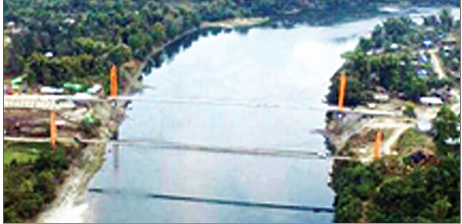
မချမ်းဘော-ပရခ-နောင်မွန်လမ်းပေါ်ရှိ မလိခတံတား (မချမ်းဘော)လုပ်ငန်းဆောင်ရွက်ပြီးစီးမှုကို တွေ့ရစဉ်
