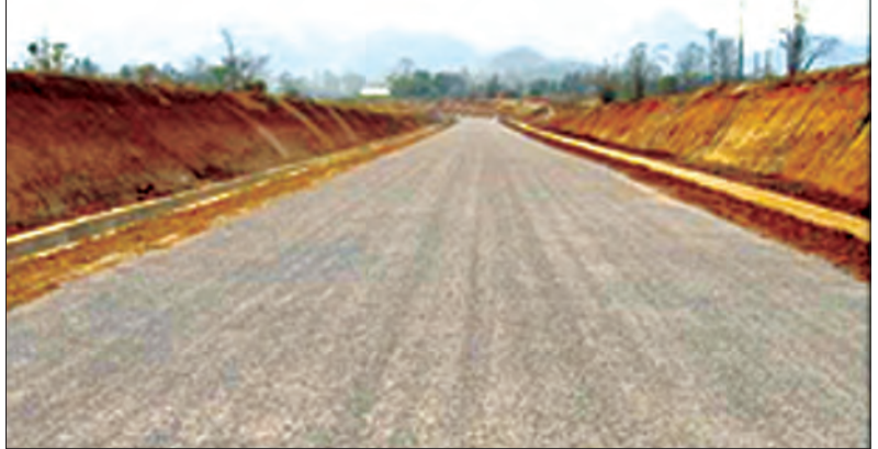
မချမ်းဘော-ပရခ-နောင်မွန်လမ်း ကီလိုမီတာ(၆၅.၈၉ - ၆၇.၂၅)အတွင်း (၁.၆ ကီလိုမီတာ)အား မူလ (3.66m) အကျယ်မှ(10.36m) အကျယ်ရသည်အထိ တောင်နံရံမြှူချ၍ လမ်းတိုးချဲ့ဆောင်ရွက်ပြီးစီးမှုကို တွေ့ရစဉ်
