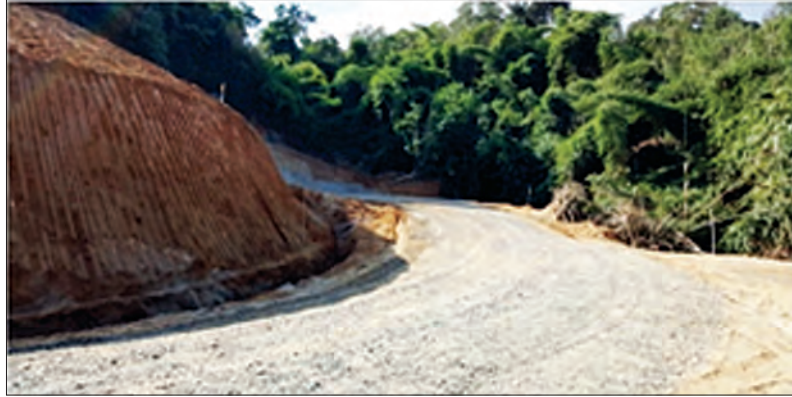
မချမ်းဘော-ပရခ-နောင်မွန်လမ်း ကီလိုမီတာ(၆၅.၈၉ - ၆၇.၂၅)အတွင်း (၁.၆ ကီလိုမီတာ)အား မူလ (3.66m) အကျယ်မှ(10.36m) အကျယ်ရသည်အထိ တောင်နံရံမြှူချ၍ လမ်းတိုးချဲ့ဆောင်ရွက်ပြီးစီးမှုကို တွေ့ရစဉ်
