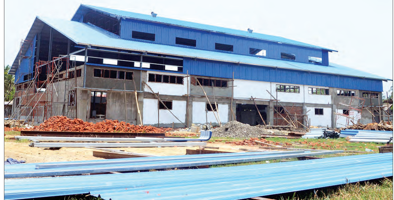
မောင်တောမြို့မအားကစားကွင်းအတွင်း တည်ဆောက်နေသော မိုးလုံလေလုံအားကစားရုံသစ်ကြီးကို တွေ့ရစဉ်
