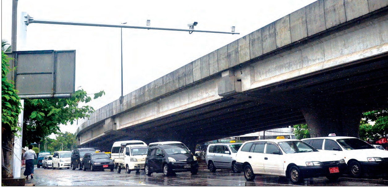
ရန်ကုန်တိုင်းဒေသကြီးအတွင်းရှိလမ်းများ လုံခြုံရေးစနစ်ပိုမိုကောင်းမွန်ရန် လုံခြုံရေးကင်မရာ(CCTV) များ တပ်ဆင်ထားမှုကို တွေ့ရစဉ် ဓာတ်ပုံ-ဇော်ကြီး
