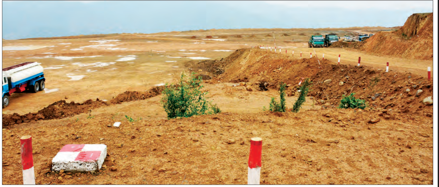
ဖလမ်းလေဆိပ်တည်ဆောက်မှုလုပ်ငန်းခွင်ကိုတွေ့ရစဉ် (ဓာတ်ပုံ-သတင်းစဉ်)
