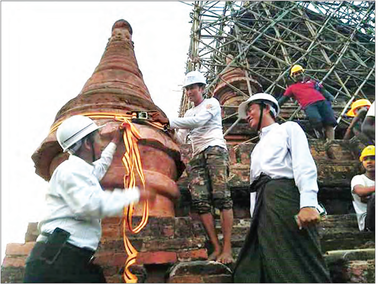
လျင်ဒဏ်သင့် ဘုရားစေတီအား နိုင်လွန်ခါးပတ်ပတ်ခြင်းလုပ်ငန်း ဆောင်ရွက်စဉ်
