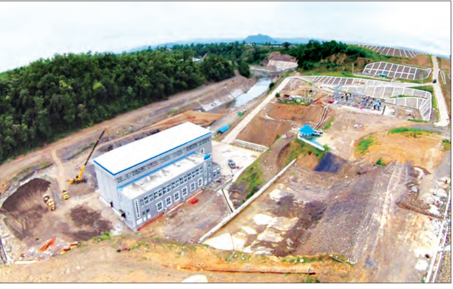
မြစ်သာရေလှောင်တံခါး ဘက်စုံစီမံကိန်း ရေအားလျှပ်စစ်စက်ရုံတည်ဆောက်ခြင်းလုပ်ငန်းများ ရက် ၁၀၀ အတွင်း အဆောက်အအုံများ တည်ဆောက်ပြီးစီးမှုကို တွေ့ရစဉ်
