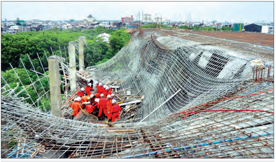
နာ၊ နာခေါင်း၊ လည်ချောင်းဆေးရုံဝင်းအတွင်းရှိ တိုးချဲ့ဆောင် ငါးထပ်လွှာရှိ ကွန်ကရစ်ကြမ်းခင်းပြုကျမှုကို တွေ့ရစဉ်
