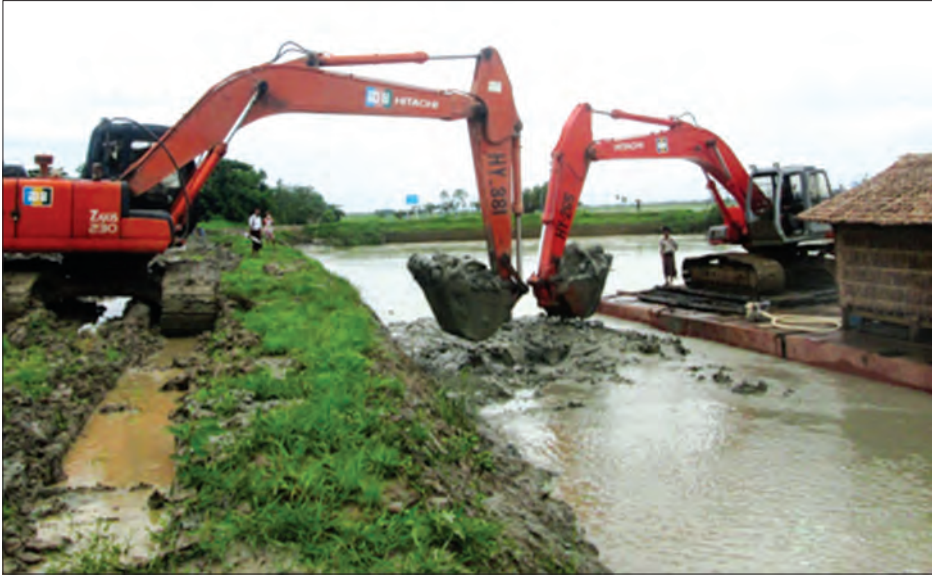
ကြက်ဖမွေးဇောင်း ကျွန်းပတ်တာအတွင်းရှိ ဖလက်ရေတံခါးအထွက်မြောင်း တူးဖော်နေစဉ်
