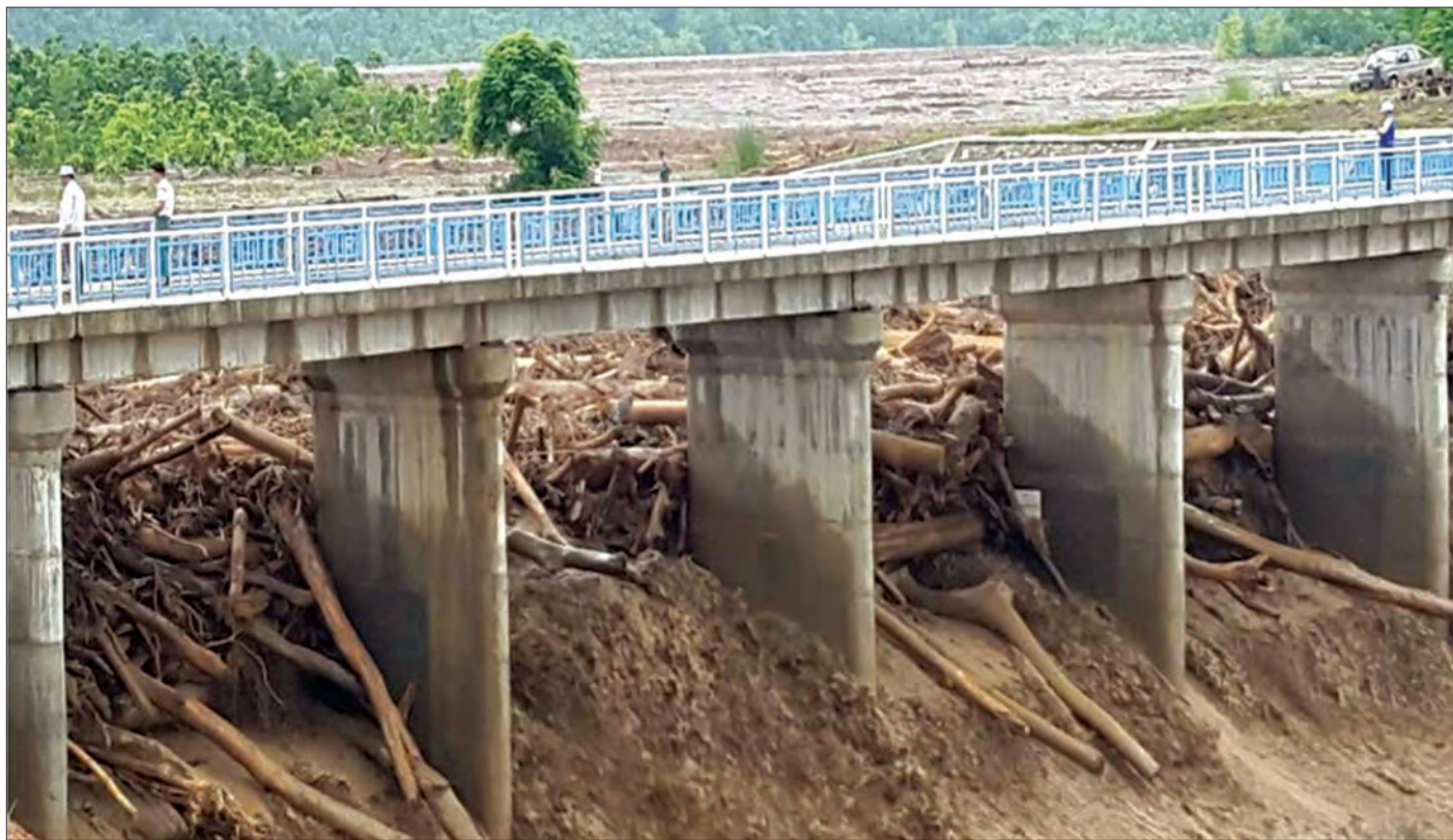
သဘာဝဘေးဒဏ်ကြောင့် ကလေးမြို့တွင် ရေကြီးရေလျှံမှုဖြစ်ပွားပြီး ရာဇဂြိုဟ်ရေလှောင်တံခံ ရေပိုလွှဲတွင် သစ်တုံးများ ပိတ်နေပုံ
