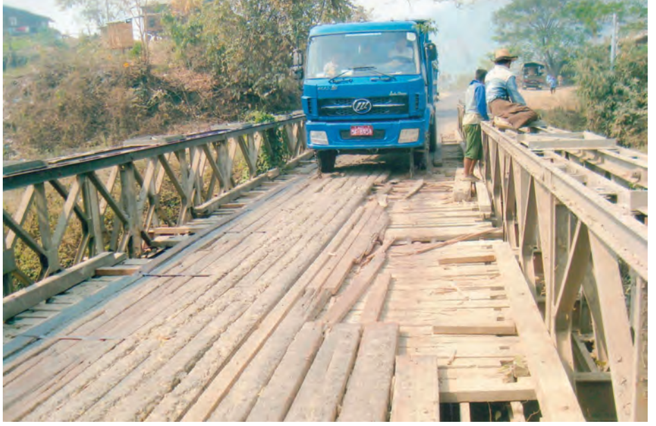
ကလေး-ကလေးဝကားလမ်း မိုင်တိုင်အမှတ် ၁၀ မိုင် ခြောက်ဖာလုံတွင်ရှိသော ကားလမ်းကူးတံတား အောက်ခြေပျဉ်များပြုတ်ထွက်ကာ ပျက်စီးနေ၍ ကားဖြတ်သွားစဉ် တုန်ခါပြီး အန္တရာယ်ဖြစ်မည်ကို ဒေသခံများနှင့် ယာဉ်မောင်းများက အထူးသတိပြုမောင်းနှင်ကြရစဉ်။
