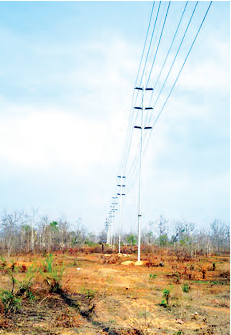
ဘော်လခဲမြို့တွင်း၌ လျှပ်စစ်ဖြန့်ဖြူးရေးအတွက် Cantilever Type 66 KV ဖြင့် ဓာတ်အား လိုင်းသွယ်တန်းထားရှိမှုကိုတွေ့ရစဉ်။
