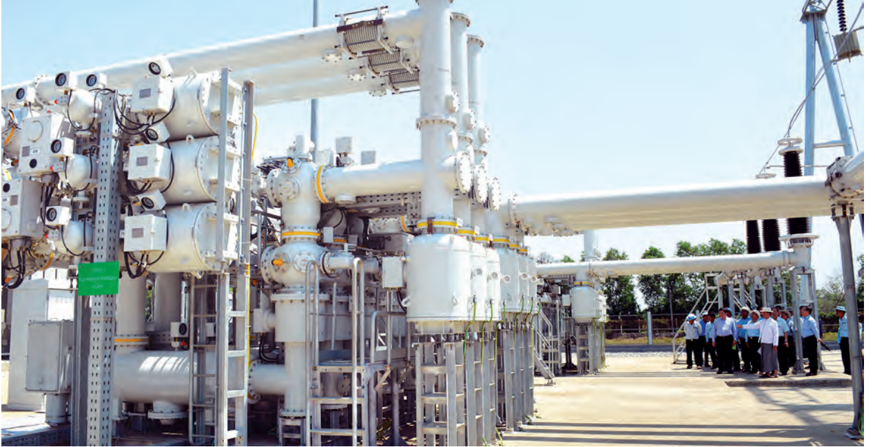
ယခု တည်ဆောက်လျက်ရှိသော 230/66/11 KV (2x125) MVA (GIS) ဓာတ်အားခွဲရုံသည် မြန်မာနိုင်ငံ၌ ပထမဦးဆုံးတည်ဆောက်သော ခေတ်မီဓာတ်အားခွဲရုံတစ်ခုဖြစ်ပြီး အဆိုပါဓာတ်အားခွဲရုံ တည်ဆောက် ပြီးစီးပါက ရန်ကုန်တိုင်းဒေသကြီးအတွင်းရှိ ဒဂုံမြို့သစ်(အရှေ့ပိုင်း)မြို့နယ်၊
