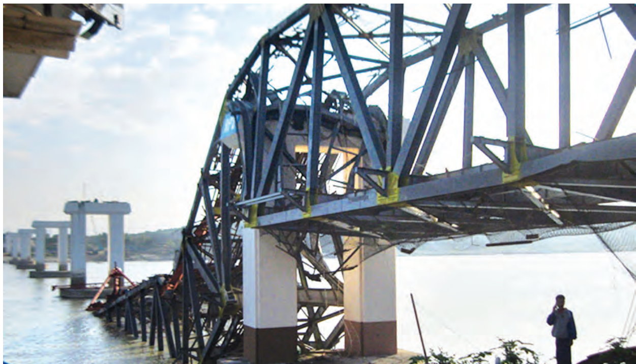
၂၀၁၂ ခုနှစ်တွင် သပိတ်ကျင်းမြို့၌ ရစ်ချ်တာစကေး ၆ ဒသမ ၈ ရှိ ငလျင်ကြီးလှုပ်ခတ်မှုကြောင့် ဧရာဝတီမြစ်ကူး ရတနာသိင်္ဃံတံတား ပြိုကျပျက်စီးမှုကို တွေ့ရစဉ်။
