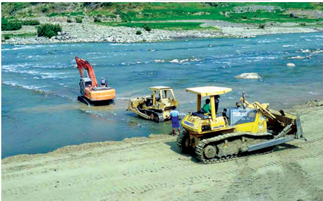
သောင်ခုံ (၂) တူးဖော်ခြင်းလုပ်ငန်းတွင် Cause Way ဆောင်ရွက်နေမှုကို တွေ့ရစဉ်။
