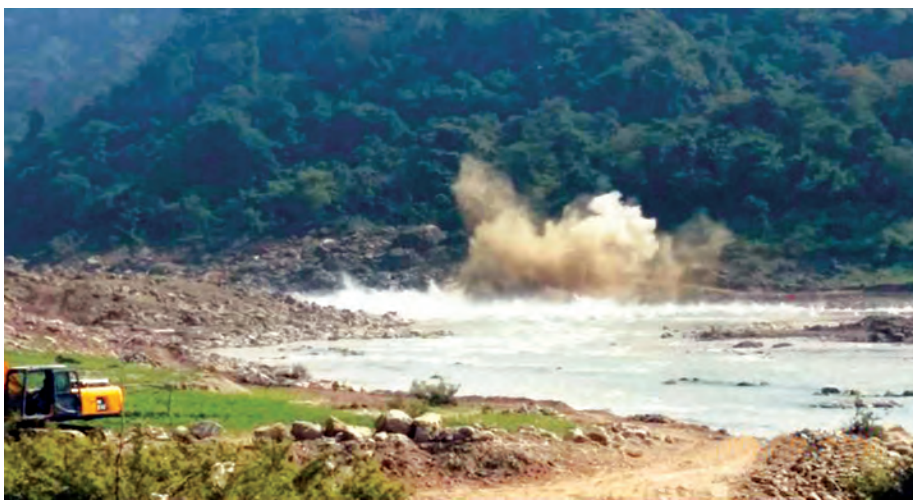
မြစ်ကျဉ်း (၃) တူးဖော်ခြင်းလုပ်ငန်း ဆောင်ရွက်ရန် မိုင်းခွဲနေမှုကို တွေ့ရစဉ်။
